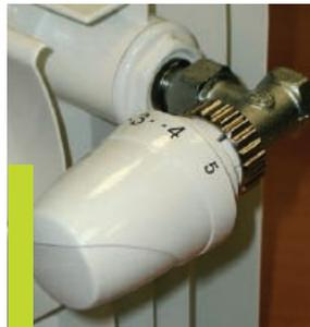
As válvulas termostáticas controlam automaticamente a entrada de água quente no radiador em função da temperatura regulada em cada comando individual. A válvula fecha-se quando a temperatura ambiente, medida por um sensor, se aproxima da temperatura desejada, permitindo o encaminhamento da água quente para os outros radiadores que ainda estão abertos ou reduzindo o funcionamento da caldeira, quando as necessidades totais da casa foram atingidas.
